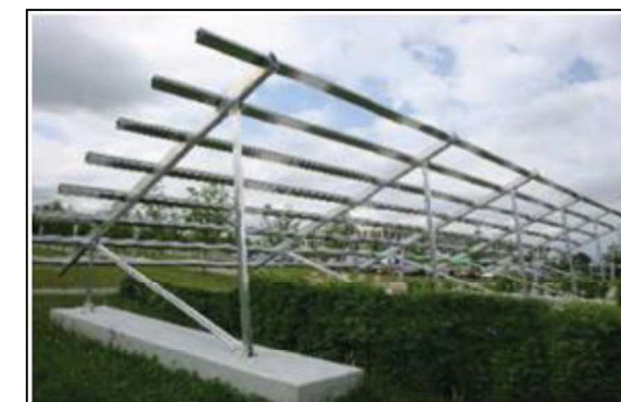
Figure 12 : Exemple de châssis métallique reposant sur des longrines béton
