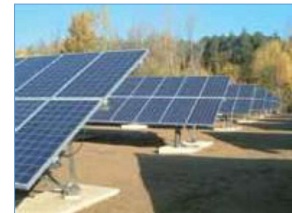
Figure 13 : Exemple de panneaux fondés sur longrines indépendantes
